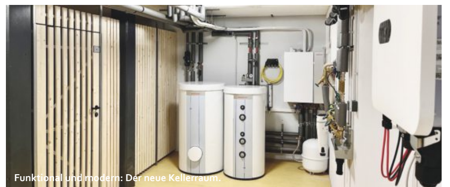
Funktional und modern: Der neue Kellerraum.
