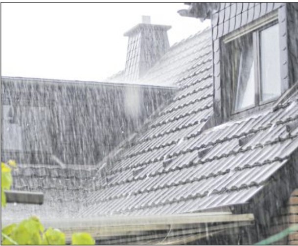
Starkregen kann innerhalb von Minuten zu lokalen Überschwemmungen führen. Foto: Roma KG
