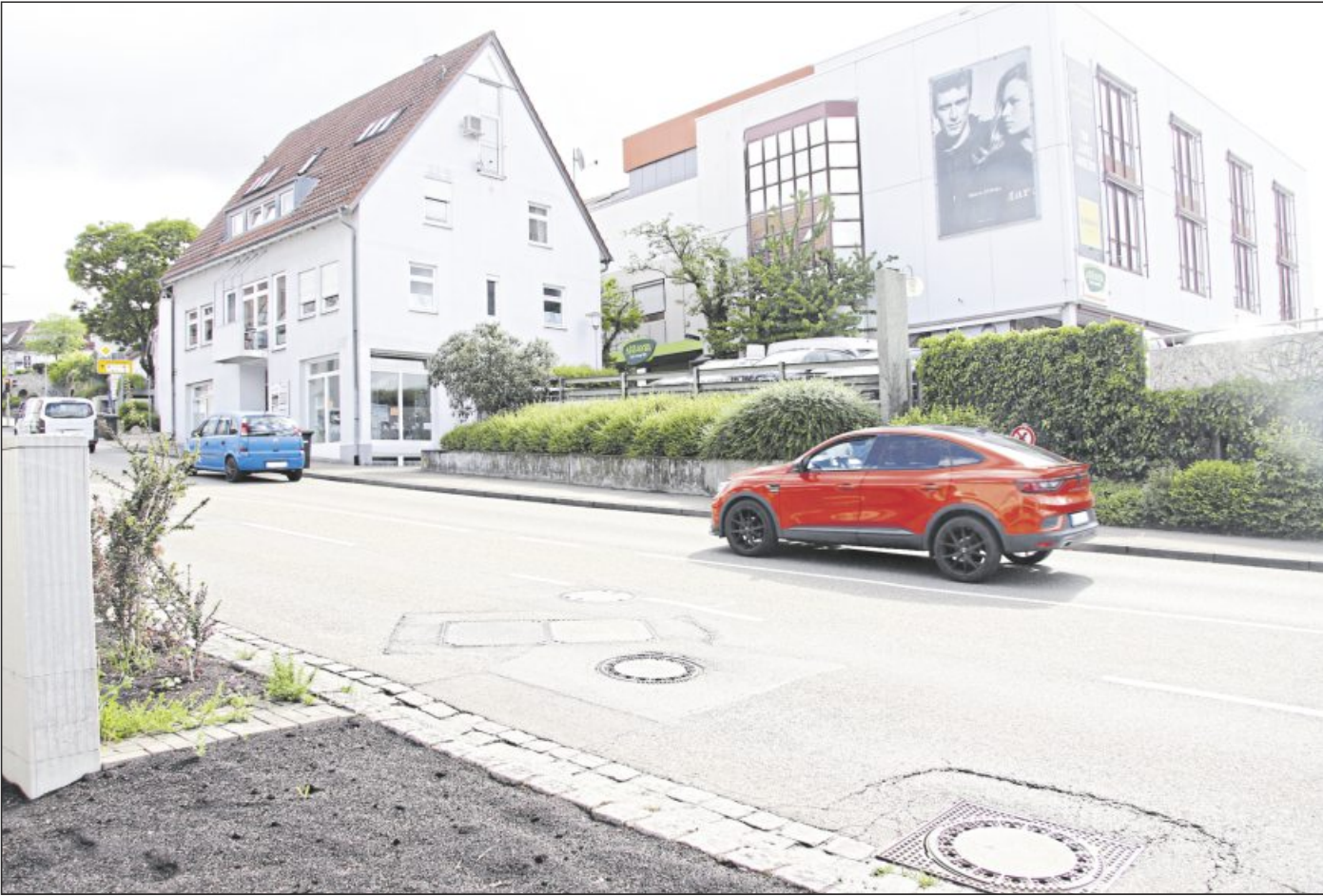
Unter der Gerberstraße liegt das Regenüberlaufbecken, das saniert werden muss. Der Verkehr wird dann einspurig in Richtung Enz an der Baustelle vorbeigeleitet. Der Gegenverkehr muss eine andere Route nehmen. Foto: Banholzer
