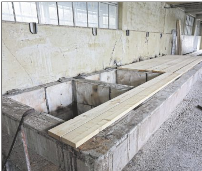
Mit Dielen werden die Becken für die Zeit der Messe gesichert.
