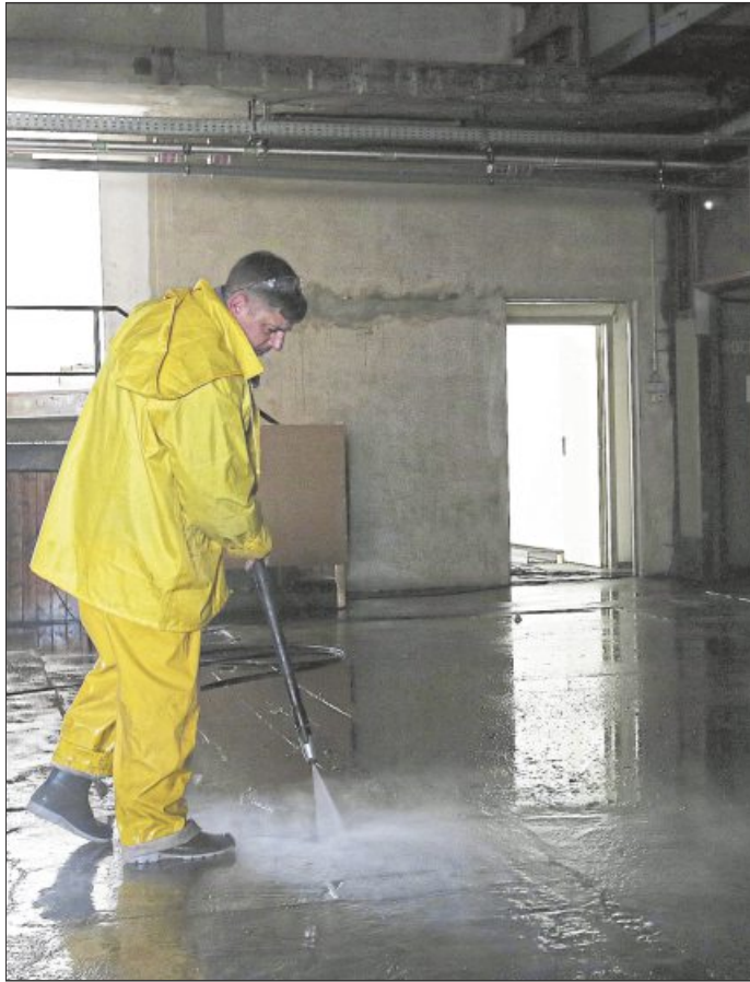
Großreinemachen in den alten Fabrikhallen.
